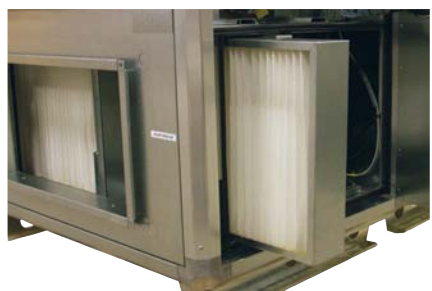
Фильтры "Minipleat" на притоке. Агрегат Systemair Torpex SR.
