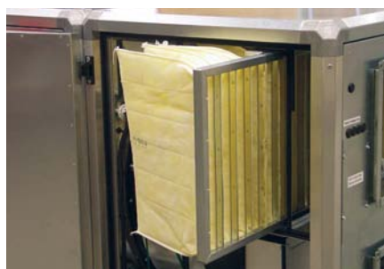
Карманный фильтр на вытяжке. Агрегат Systemair Torpex SR.
